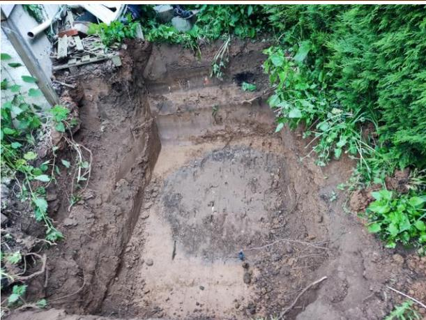
Photographie 5 : Apparition de tuyaux polyéthylène à environ 0,9m de profondeur
