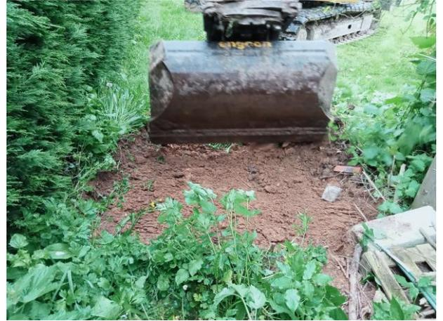
Photographie 2 : Décapage réalisé avec une pelleteuse munie d'un godet cureur
