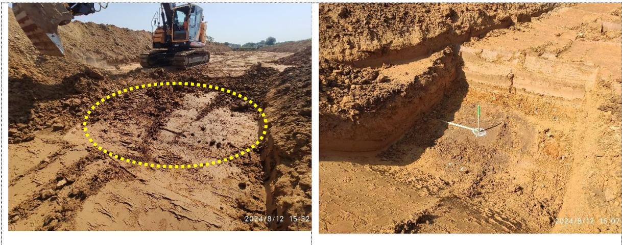
**Au vu du constat de terrain, cette anomalie s'apparente à un ancien puits de carrière remblayé.**
