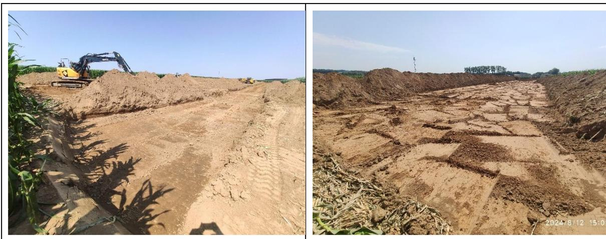
Le décapage effectué sur une profondeur de l'ordre de 70 cm a mis en évidence la présence de formations limoneuses en place. En fond de fouilles, plusieurs anomalies ont été identifiées et ont alors fait l'objet d'un sondage à la pelle systématique afin d'en définir la nature.
