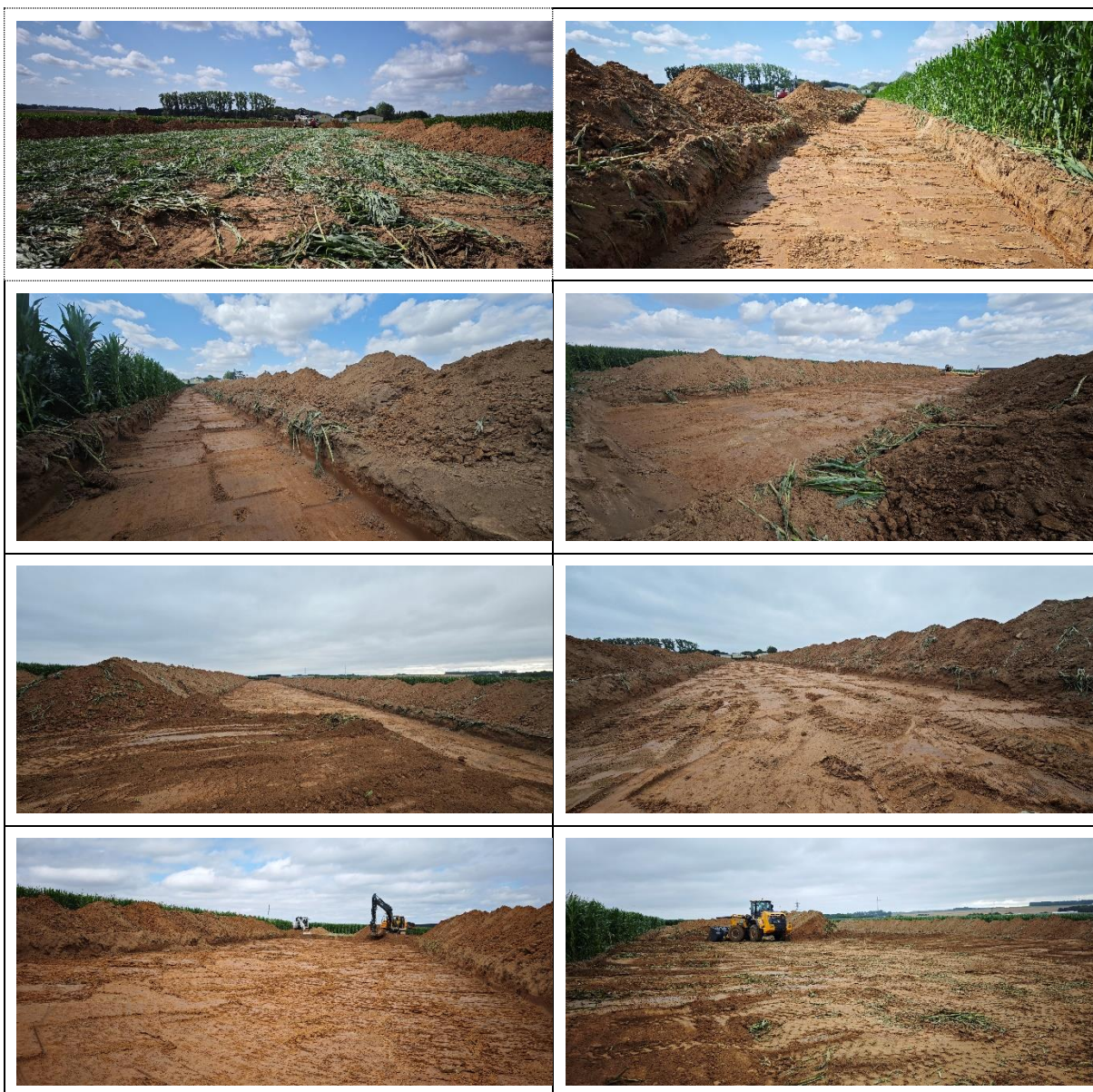
Schéma 6 : Vues des travaux de décapage au droit des ICS160&161 (Crédit photo explor-e)
