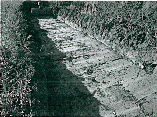
**Photographie 1 : Décapage par lames successives de 0,2 à 0,3 m à l'aide d'un godet cureur**
