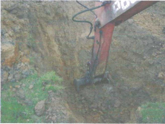
**Photographie 1 : Décapage à la pelle mécanique**
