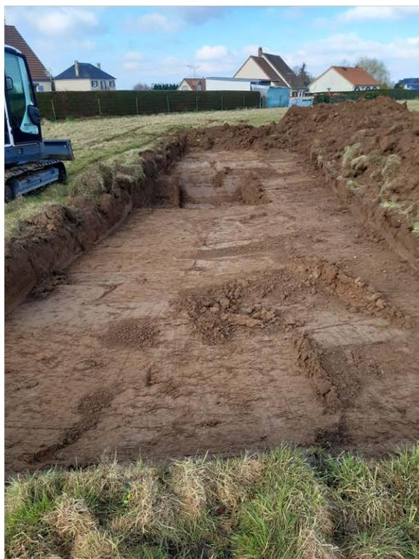
**Photo n°4 : Vue vers le Nord-Ouest de la 1<sup>ère</sup> et 2<sup>ème</sup> bande décapées sur 4,6 m de large environ**
