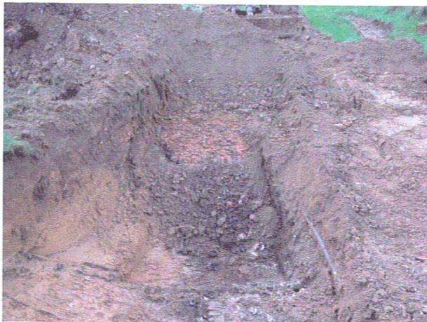
*Mise en évidence d'argile à silex décomprimée et d'une canalisation d'eau*
