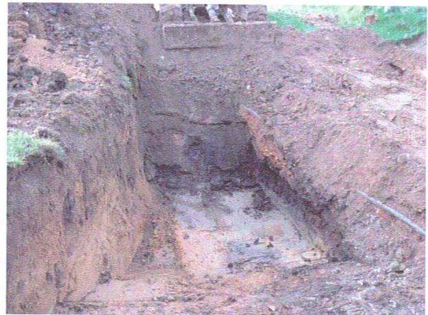
*Persistance des remblais sous la canalisation à 3.5 mètre de profondeur, fin du sondage.*
