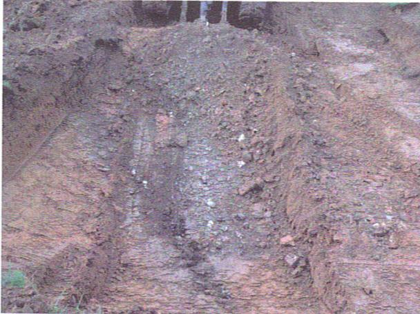
*Présence de remblais divers à 1.2 mètres de profondeur (brique, craie, ferraille)*
