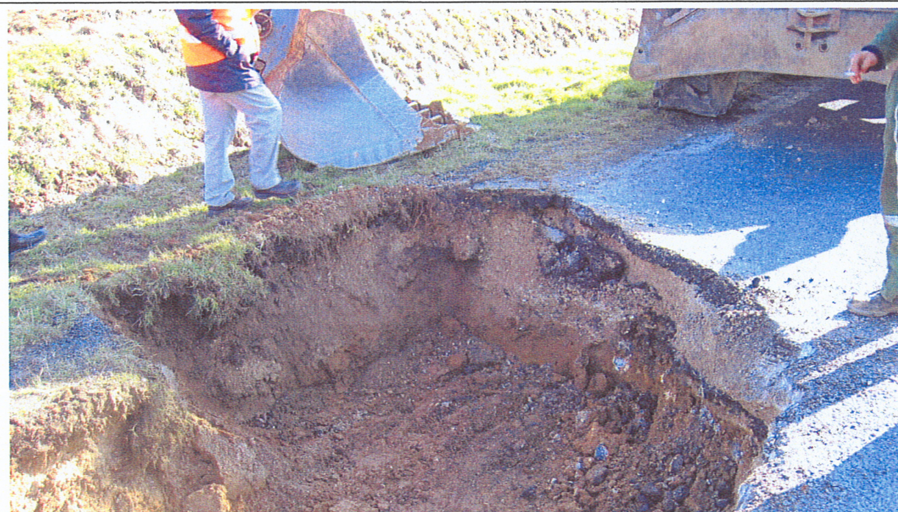
Fond de fouille
