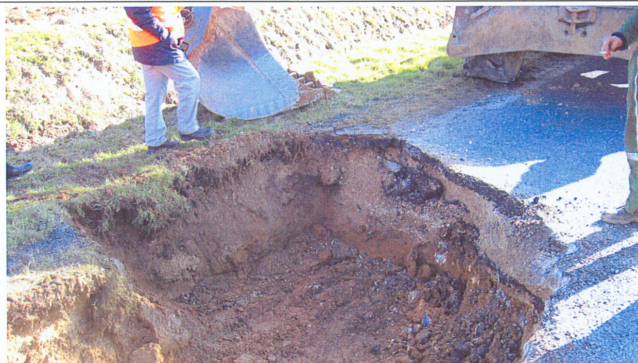
Fond de fouille
