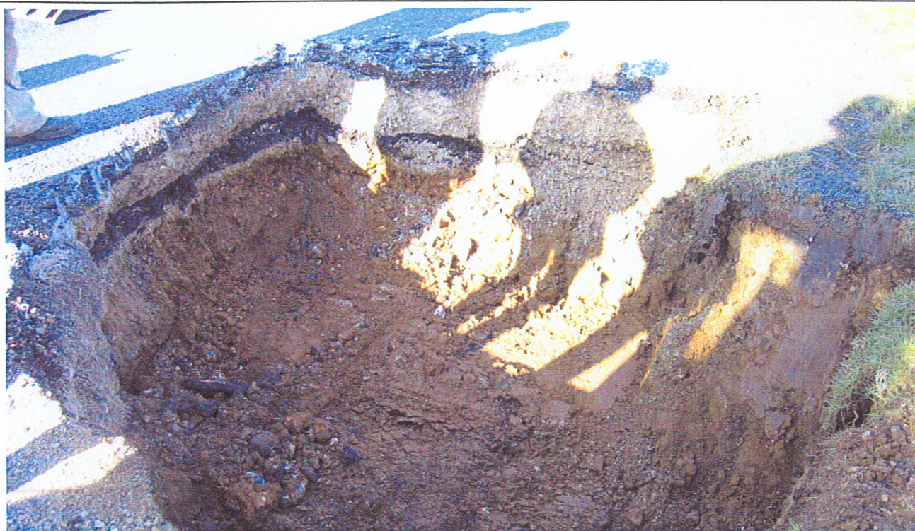
Les différentes couches de chaussées sont observables
