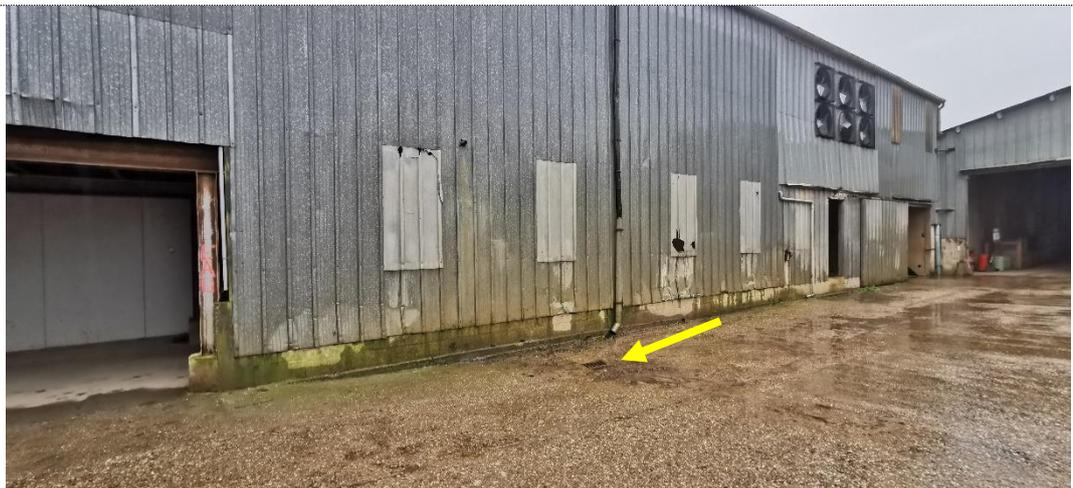
Eaux de la toiture et de la plateforme collectées par le regard au nord du bâtiment. Ces eaux transitaient sous le hangar via un réseau avant de rejoindre le regard situé au sud du bâtiment.
