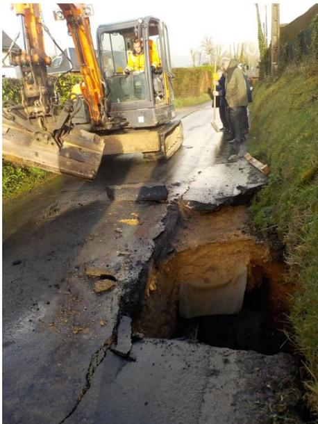
**Photographie 7 : Ouverture partielle de l'effondrement avant comblement**
