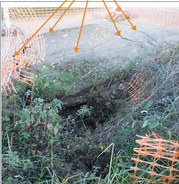
Figure 3: Effondrement et affaissement observés le 26 octobre 2022. Photo prise en direction des champs alentours, dos à la RN27.
