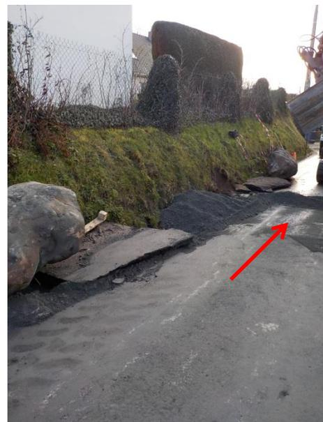
**Photographie 8 : Comblement de l'effondrement avec poche de vide résiduelle sous la chaussée**
