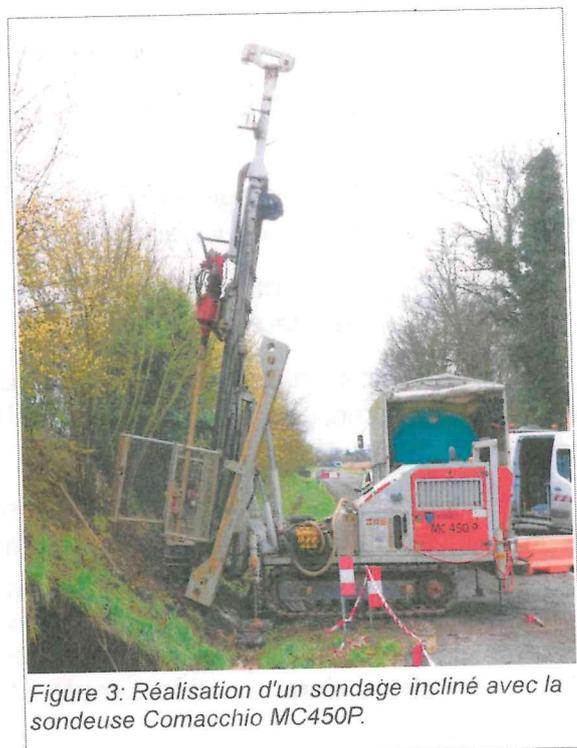
Figure 3: Réalisation d'un sondage incliné avec la sondeuse Comacchio MC450P.
