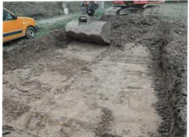
**Photographie 2 : Décapage réalisé avec une pelle munie d'un godet cureur**
