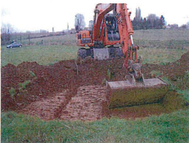
**Photographie 5 : Surcreusement dans les limons « ocre », mise à jour d'une arrivée d'eau**
