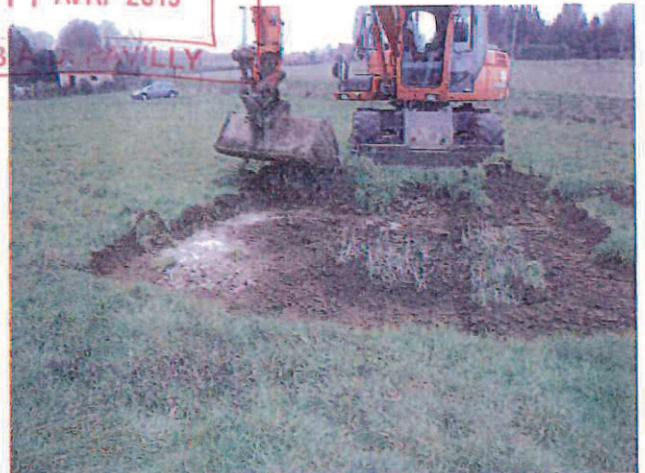
**Photographie 2 : Décapage au godet cureur, dans les limons. Présence de remblais de type dépôt de marne**
