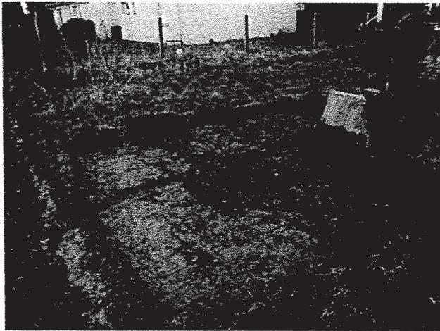
**Photographie 3 : Décapage par lame de 0.2 à 0.3 m de profondeur et surcreusement**
