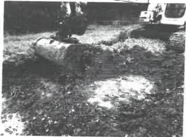
**Photographie 2 : Affouillement du sol au godet cureur par lames de 20 à 30cm**
