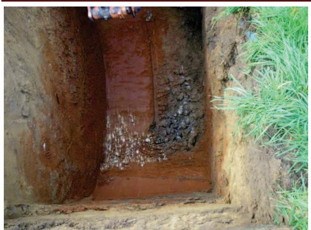
**Photographie 6 : Fin de chantier avec apparition de trace de marne**
