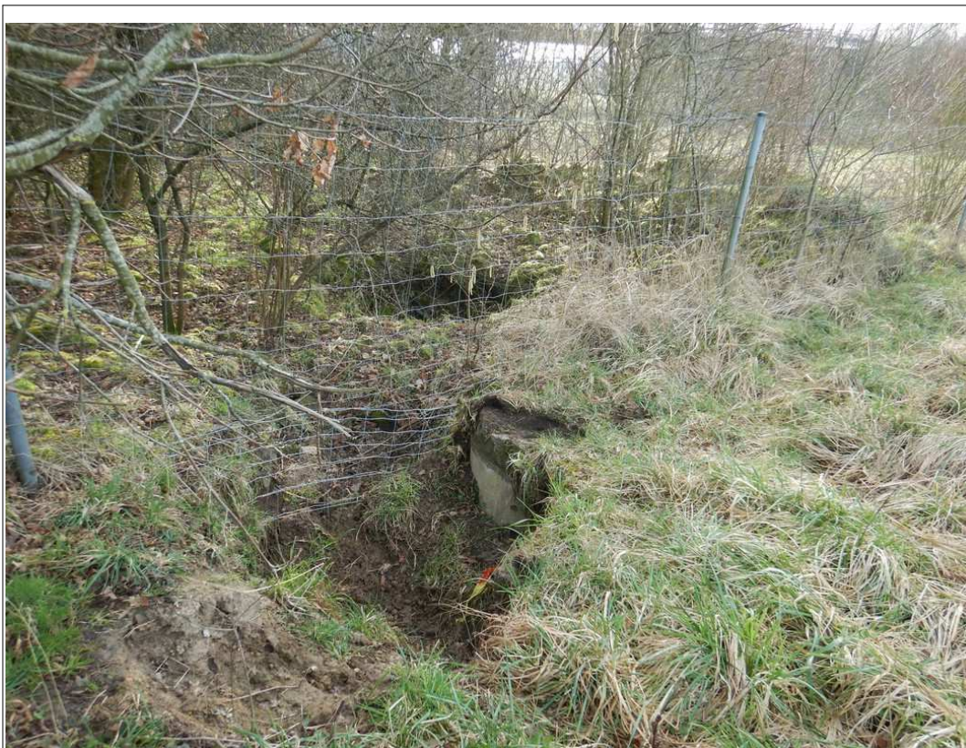
4. Illustration: Buse correspondant au puits d'accès de la marnière SAPN 31 traitée
