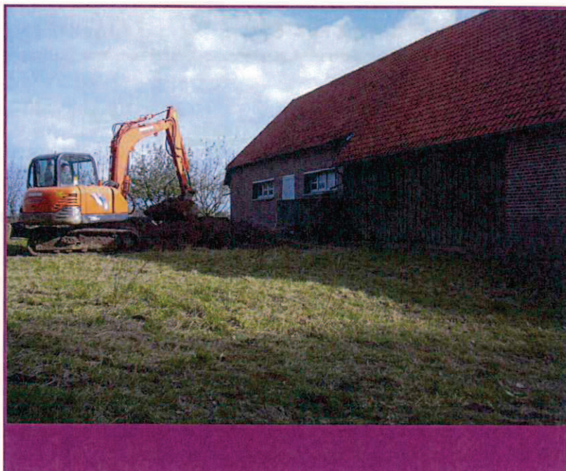
Photo 1 : Matériel de terrassement employé
