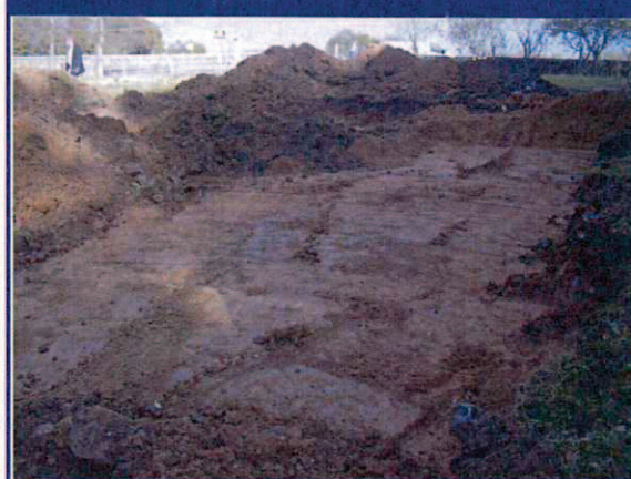
Fin du décapage
