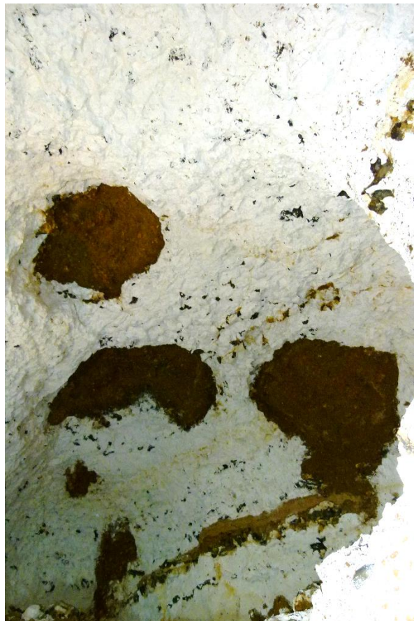
Base de racines remplies de formation résiduelle à silex recoupées par l'exploitation d'une marnière (Routot – Crédit photo : Explor-e)
