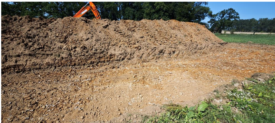
Schéma 11 : Exemple 3 - Formation à silex très charpentée en fond de fouille au niveau d'une zone non remblayée
