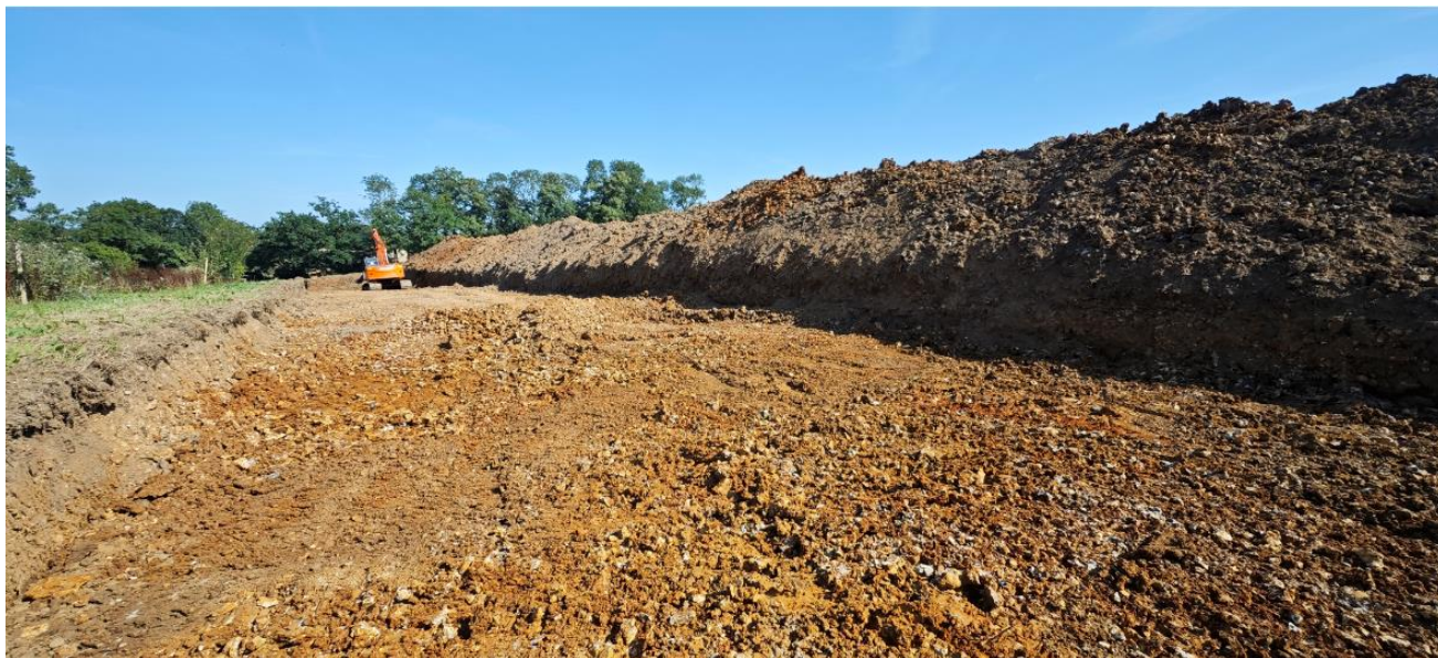
Schéma 12 : Exemple 4 - Formation à silex très charpentée en fond de fouille
