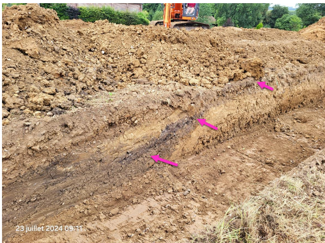
Schéma 9 : Exemple 2 - aperçu d'un fond de fouille lors du décapage au niveau d'une zone anciennement remblayée nécessitant un surcreusement afin de retrouver les terrains n place « originels »
