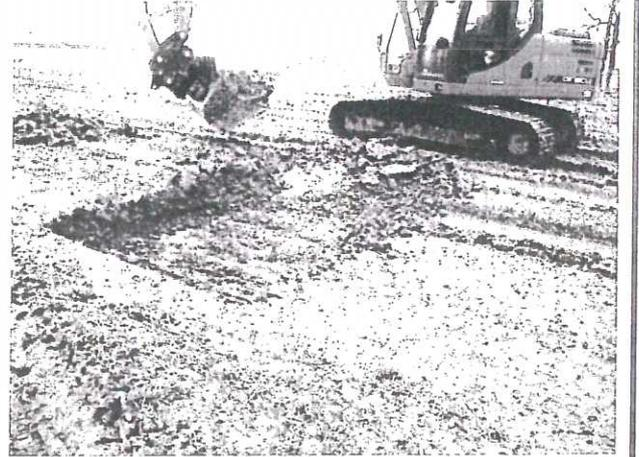
**Photographie 2 : Décapage au godet cureur par lame de 20 cm**
