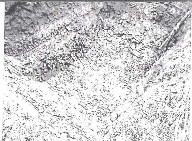
**Photographie 13 : Surcreusement jusqu'à 3 m de profondeur dans le terrain naturel (argile à silex)**
