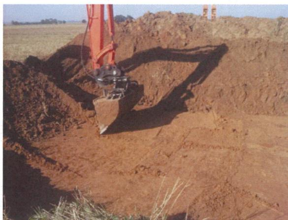
**Photographie 2 : Décapage au godet cureur par lame de 20 à 30cm**
