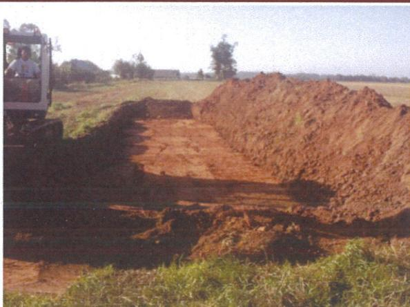
**Photographie 3 : Décapage réalisé en tranchées successives**
