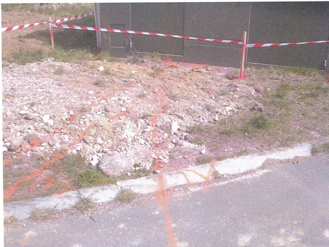
Forages situés devant le transformateur, les tracés de couleur indiquent l'emplacement des conducteurs électriques
