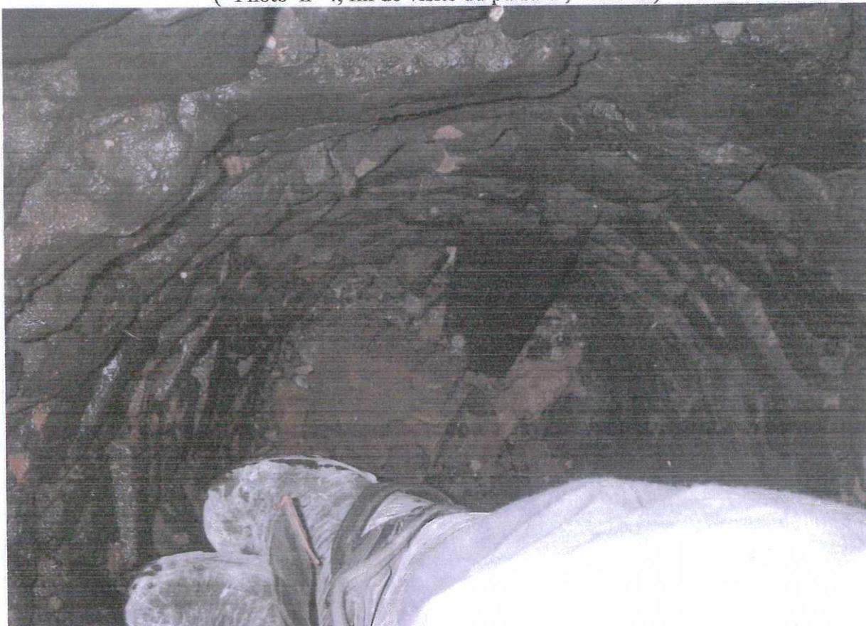
(- Photo n° 5, curage de l'ancien puisard impossible, diamètre du puits trop étroit)
