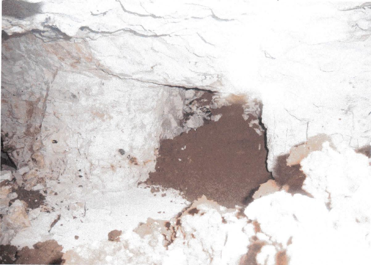
(Photo n° 11 : Léger effondrement sur pelouse : ancien puits d'accès en surface).
