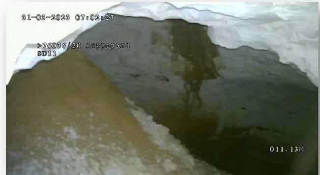
*Vue sur la chambre direction Ouest et sur SD5 (écoulement des boues sur le flanc de la marnière)*
