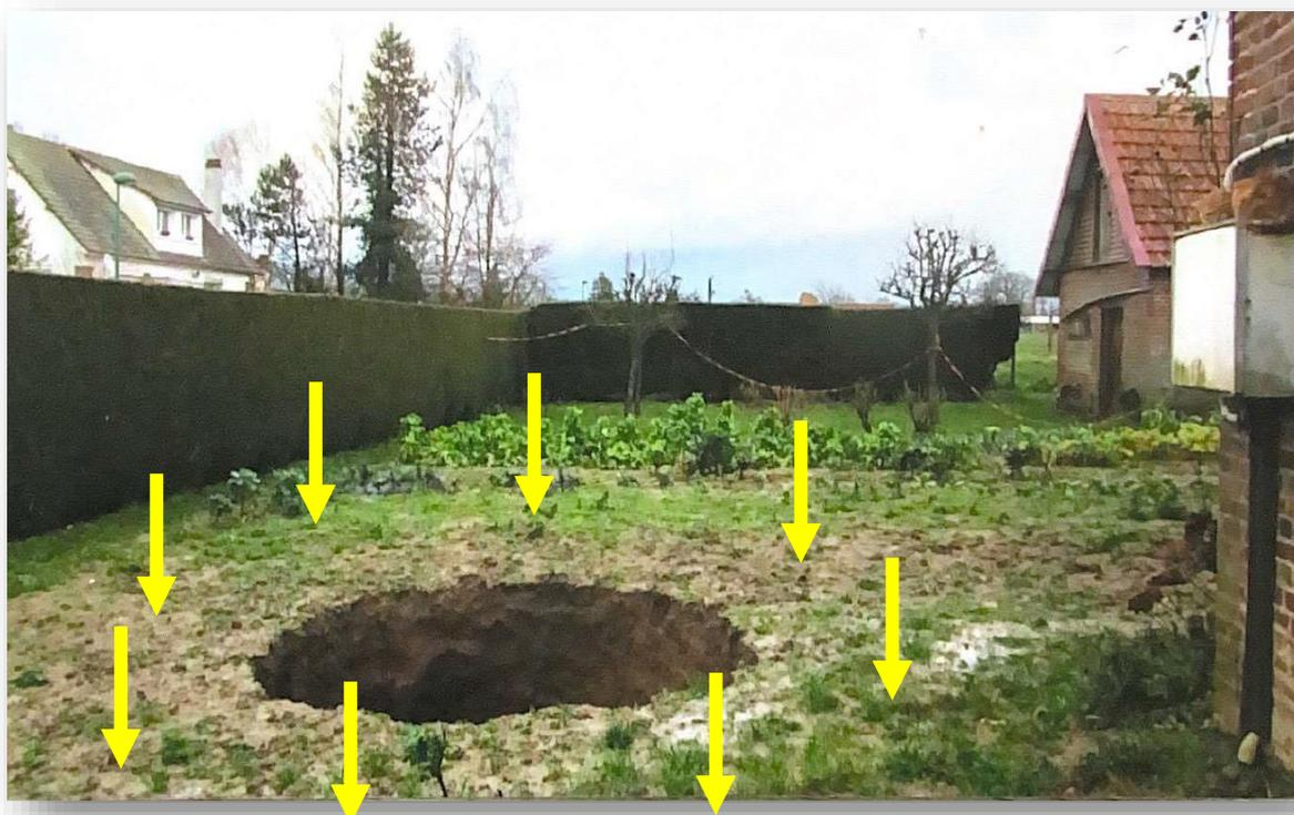
Ce programme (implantation et profondeur des sondages) pourra être adapté au cours des investigations en fonction des anomalies identifiées. Ainsi, si un vide est reconnu lors de la réalisation de ces sondages, la réalisation d'inspections vidéo sera proposée (cf. chapitre 4).
