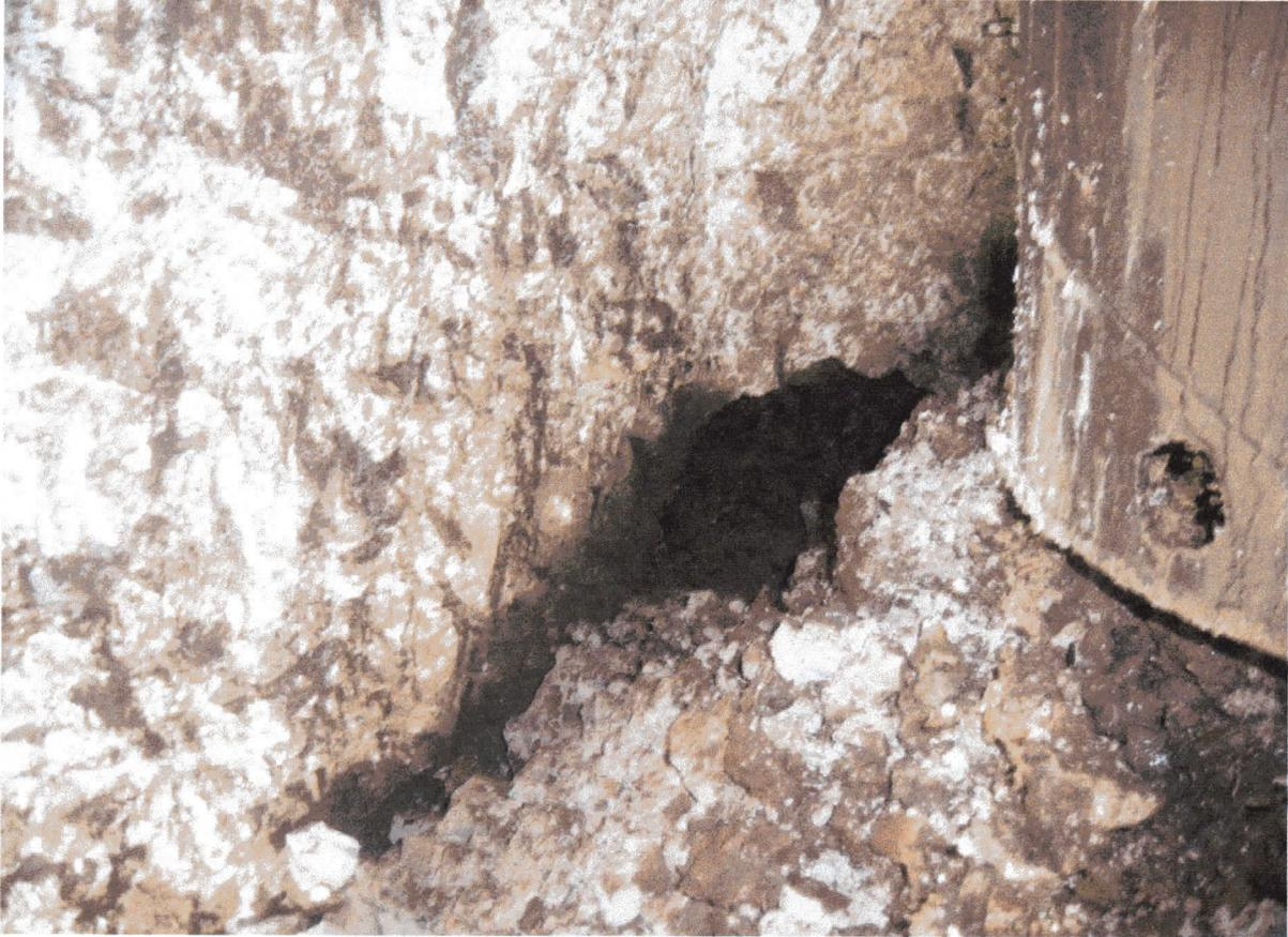
(Photo n° 5 : Base du puits neuf, effondrement des argiles).
