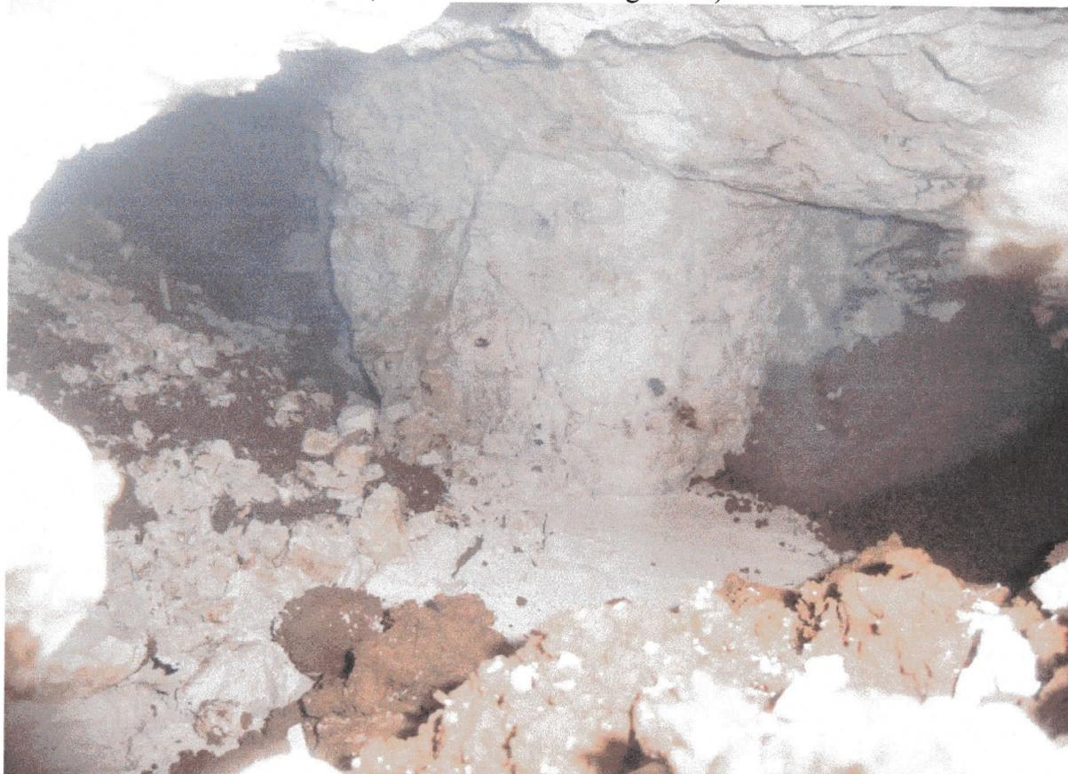
(Photo n° 9 : Effondrement important des argiles).
