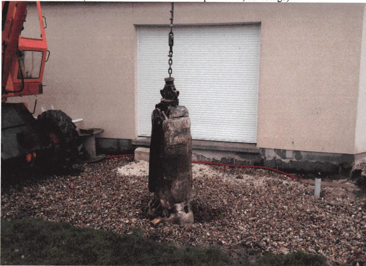
(Photo n° 3 : Creusement d'un puits neuf, - 6.20m galerie percée)
