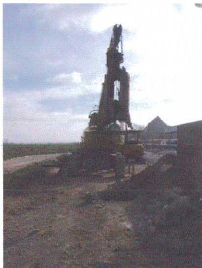
Creusement à la benne preneuse
