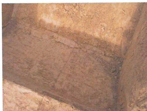
*Photo n°7* : Observation d'un terrain naturel limoneux (non remanié) sous les morceaux de bois en phase de décomposition.
