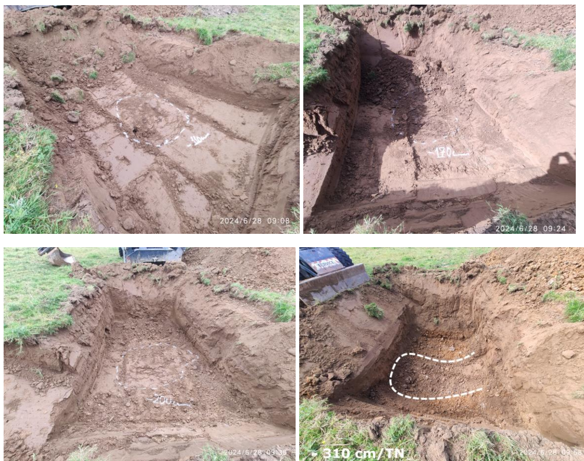
Schéma 8 : Anomalie de terrain et sondage à la pelle mécanique à son endroit.
