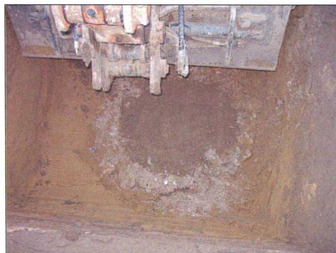
**Photos 3 et 4 :** Trace identique de 1 m à 2,5 m de profondeur, remblai de terre entouré de silex et de chaux mélangé d'un diamètre d'environ 1 m.
