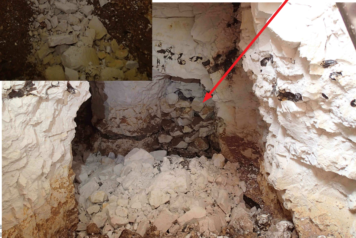
Mur en pierres sèches dissimulant le puits
