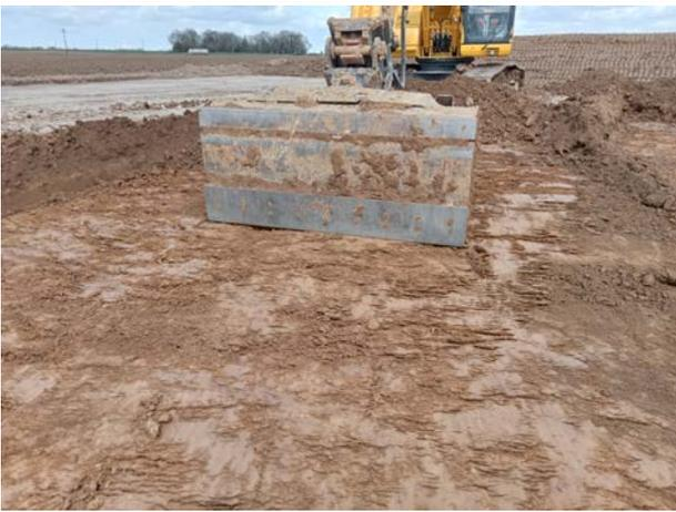
**Photographie 3 : Décapage réalisé par bandes successives**
