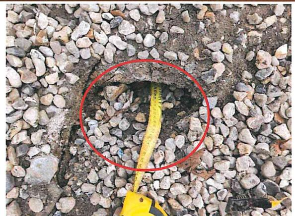
**Photographie 6 : Elargissement en profondeur des dimensions de l'effondrement avec terrains en surplomb**
