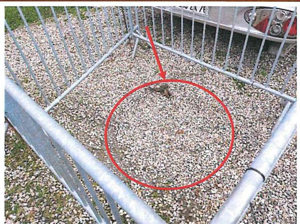
**Photographie 4 : Présence d'un effondrement en bordure de la cuvette**
