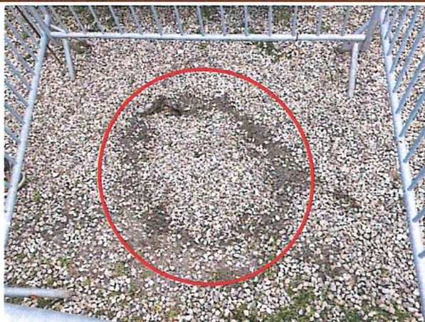
**Photographie 3 : Cuvette de forme ovale d'environ 0,8m de large par 1,1m de long**
