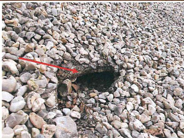
**Photographie 5 : Effondrement se développant côté opposé à la cuvette**
