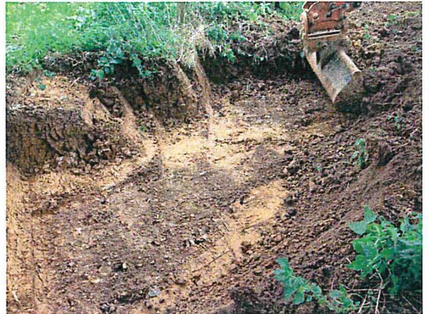
Photographie 2 : Décapage organisé en tranchées successives. En fond de fouille, l'argile à silex reste visible.
