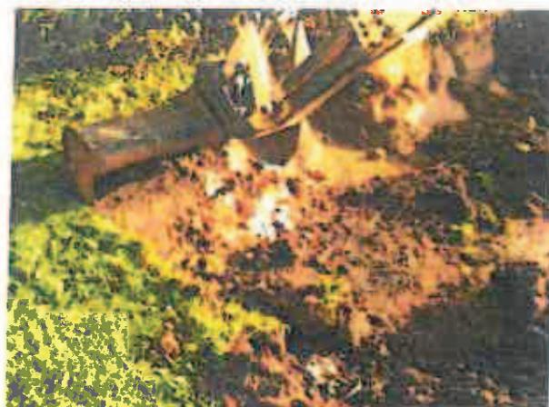
**Photographie 2 : Décapage par lames de 0,20 à 0,30m au godet cureur**
