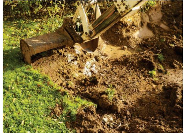
**Photographie 2 : Décapage par lames de 0,20 à 0,30m au godet cureur**
