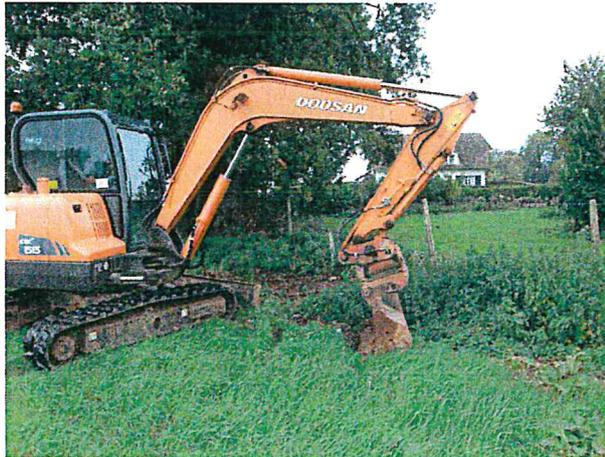
Photographie 1 : Décapage au godet cureur par lame de 20 à 30cm
