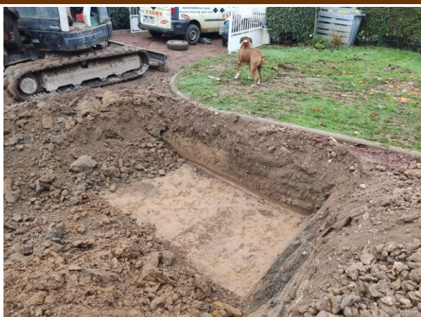
Photographie 3 : Décapage réalisé par zones successive afin de ne pas abimer les bordures en béton
