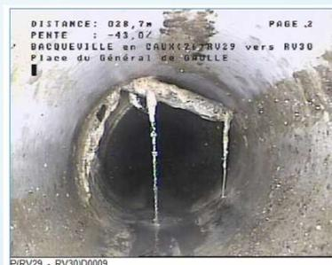
Figure 1 : Infiltration - RV 29 à RV 30 - Place du Général De Gaulle
